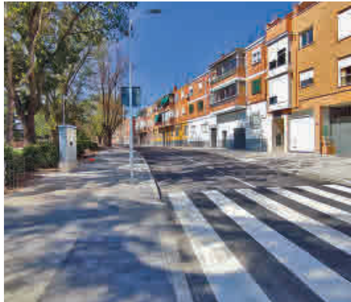
Uno de los tramos mejorados en la primera fase de las obras
