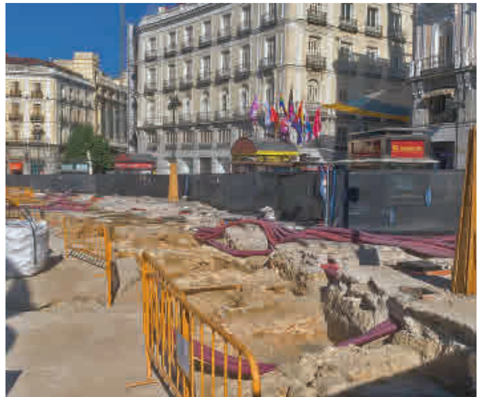
Los trabajos de remodelación de la Puerta del Sol @MADRID_SECRET0
