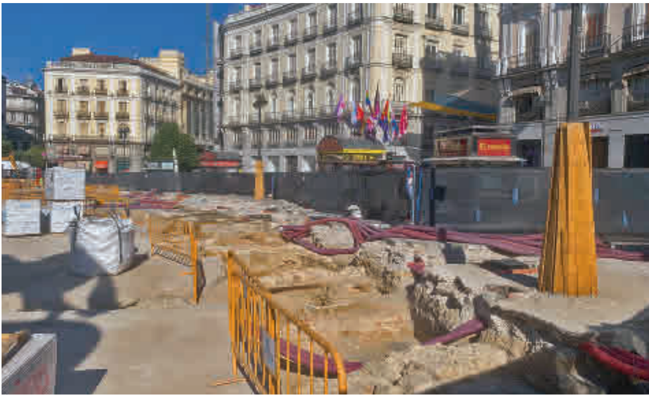
Los trabajos de remodelación de la Puerta del Sol @MADRID_SECRETO
