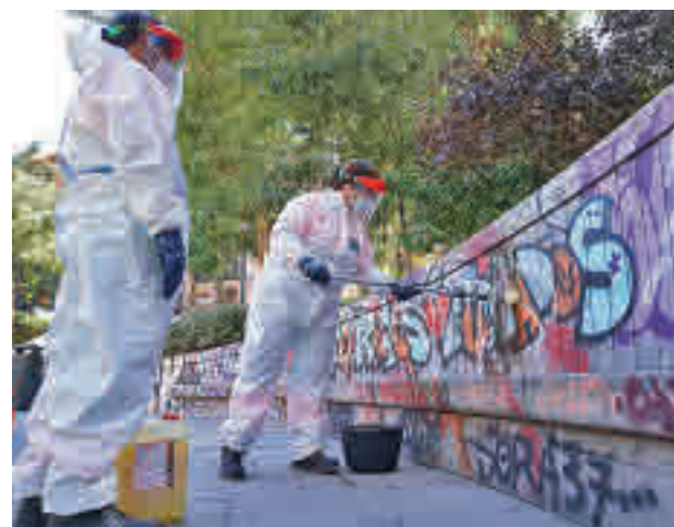
Un operario limpia un muro en la plaza del Dos de Mayo
