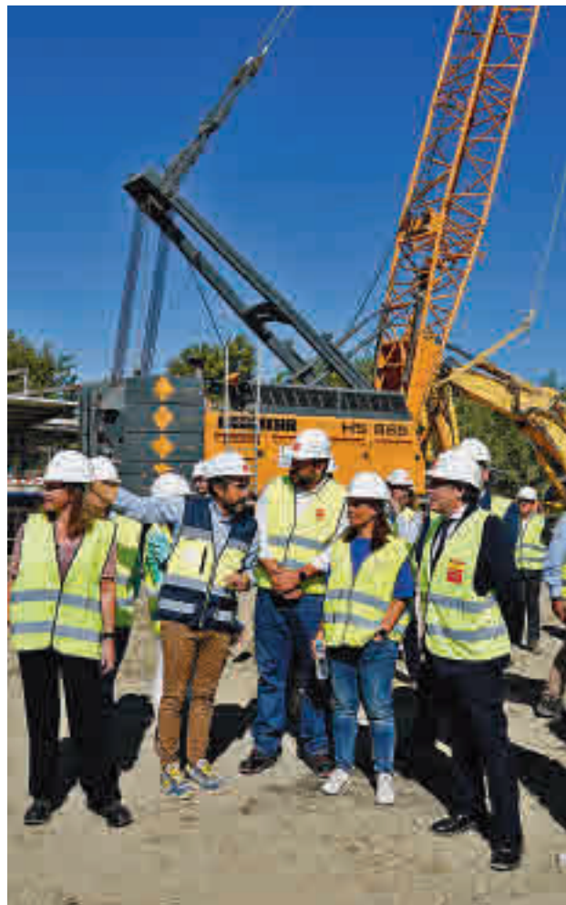
Visita a las obras de ampliación de la Línea 3
