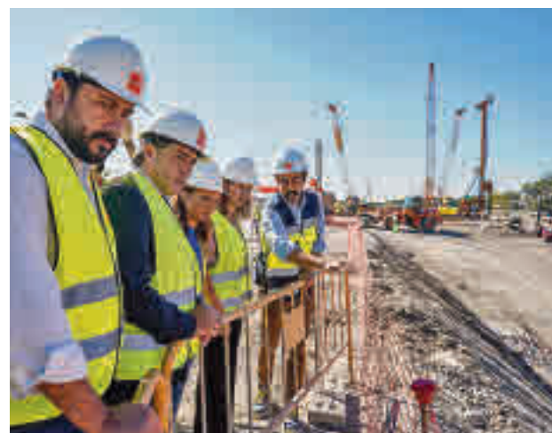
Visita a las obras de ampliación de la Línea 3
