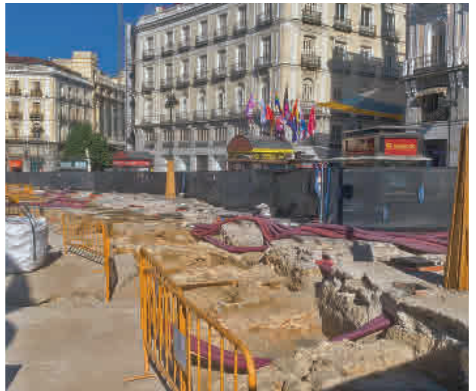
Los trabajos de remodelación de la Puerta del Sol @MADRID_SECRETO
