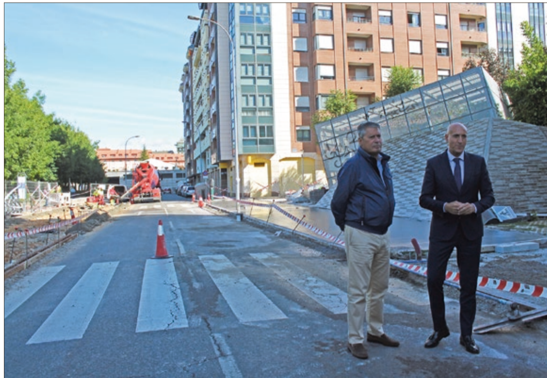
José Antonio Diez y Luis Miguel García Copete visitaron las obras de semipeatonalización de la calle Santos Olivera.
