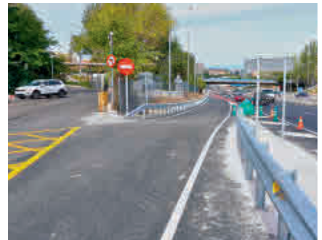
El nuevo ramal de conexión
