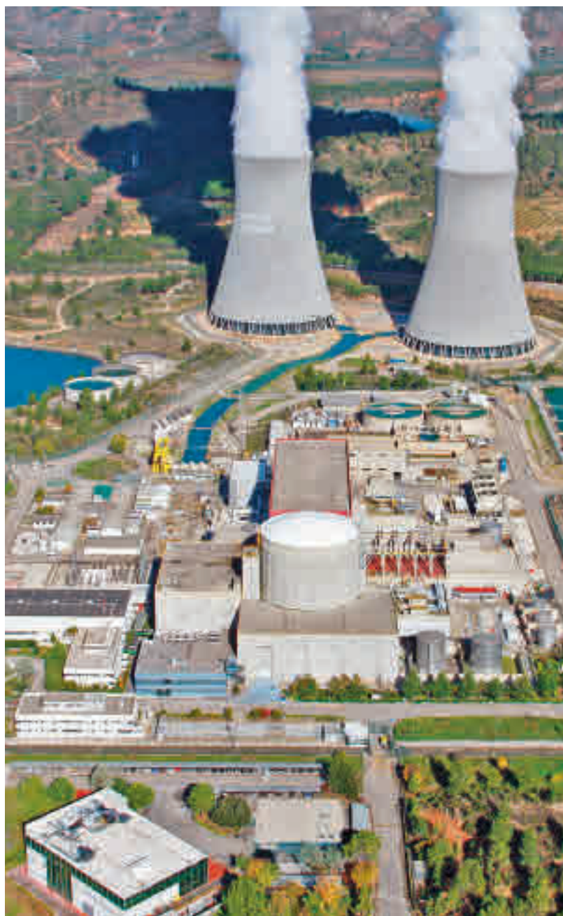
Panorámica de la central nuclear de Cofrentes
