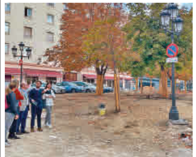
El concejal de Centro visitó las obras el lunes 17 de octubre
