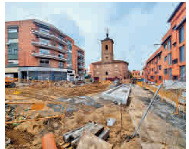
Estado actual de las obras
