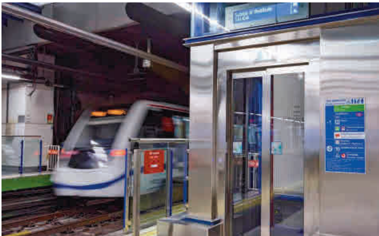
Actual estación de la Línea 11 de Metro
