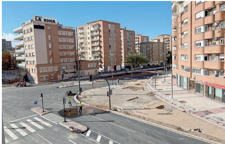
La evolución de los trabajos del Nudo de Vara de Rey.
