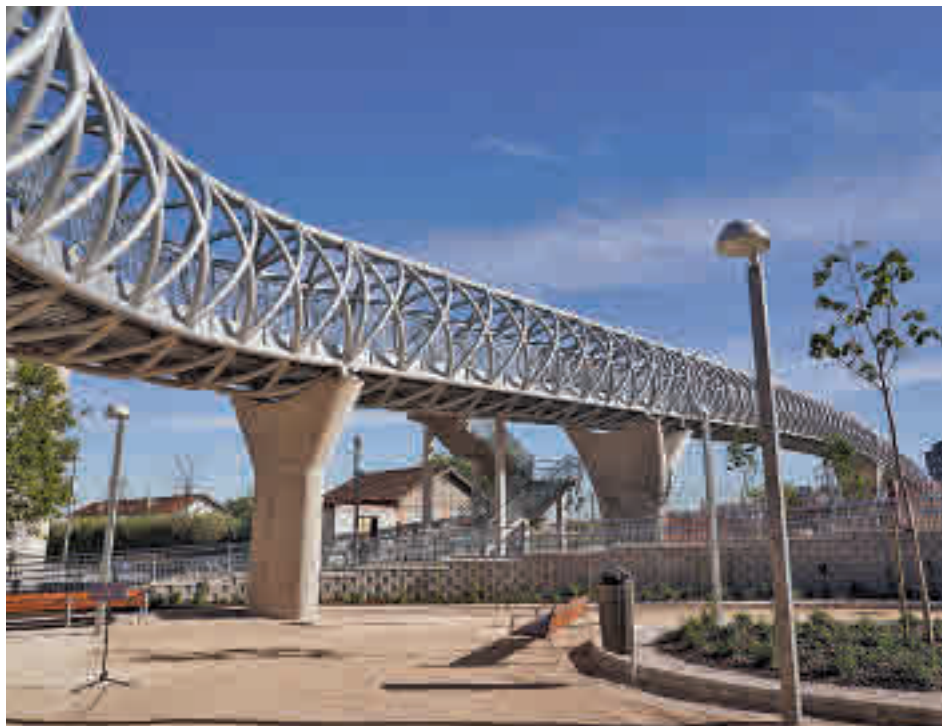
La nueva infraestructura peatonal que cruza por encima de las vías del tren
