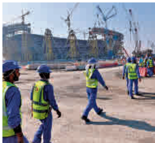
Trabajadores en los estadios
