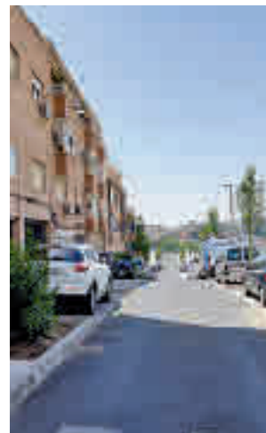
Obras terminadas en Alberdi
