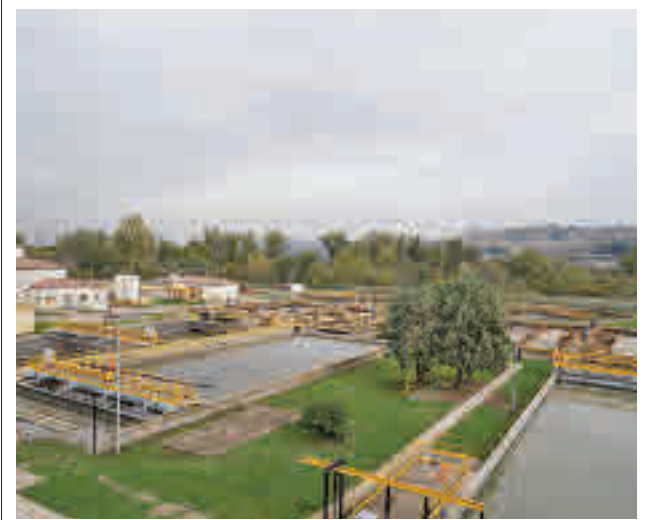
Estado actual de las instalaciones
