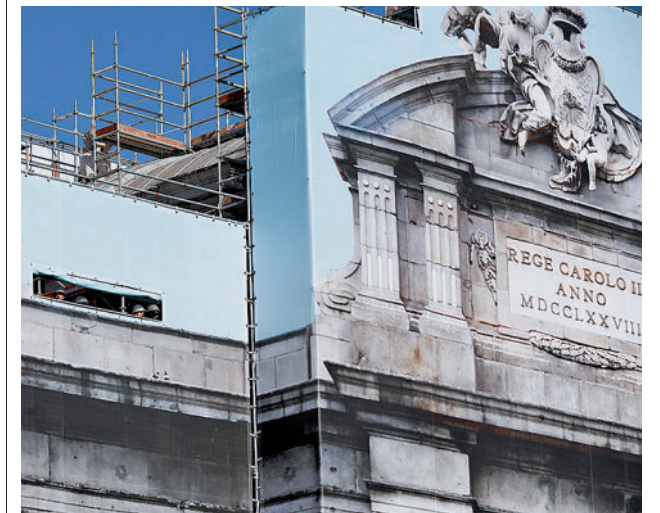
Los andamios instalados en la Puerta de Alcalá
