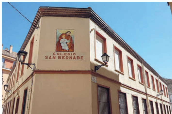
El Colegio San Bernabé, cuya remodelación no tuvo licitador.
