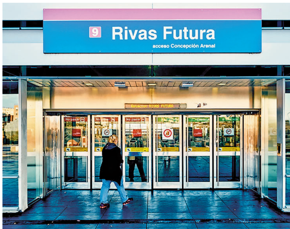
Estación de Rivas Futura AYTO. RIVAS
