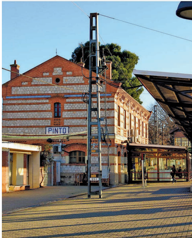
Estación de Cercanías de Pinto
