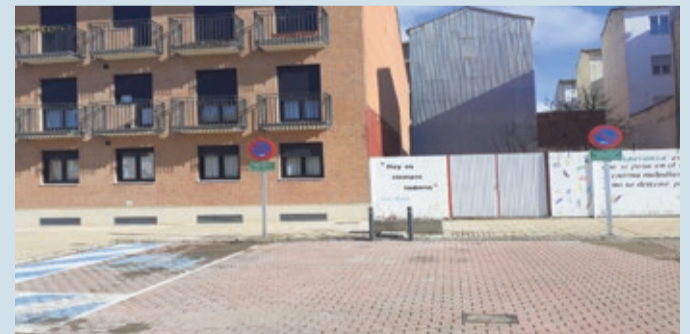
Próximo punto de recarga eléctrica en la Av/ Doctores Bermejo y Calderón.
