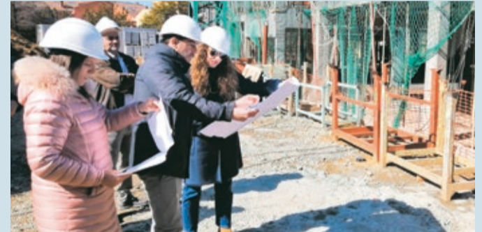
La delegada de la Junta visitó el estado de las obras del nuevo centro de salud.
