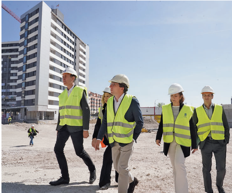
El alcalde, José Luis Martínez-Almeida, durante la visita a las obras
