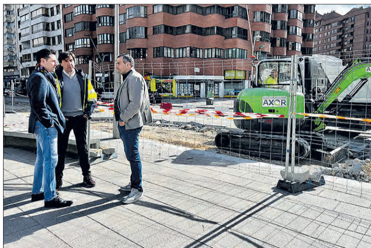
El alcalde de Burgos, Daniel de la Rosa, visitó el día 22 las obras del carril bici de Reyes Católicos, acompañado por el concejal de Movilidad, Levi Moreno.
