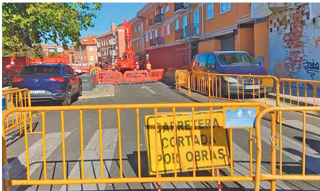
Máquinas trabajando en la demolición de un edificio de El Pilar AYTO. SAN FERNANDO DE HENARES
