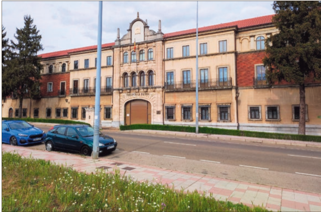
Antiguo cuartel de Almansa, ubicado en la carretera de Asturias, que Díez propone para viviendas de alquiler social.
