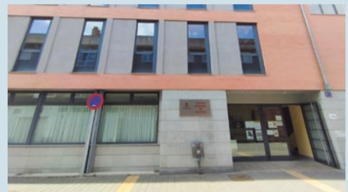
Fachada del Centro Municipal de Personas Mayores de Trobajo del Camino.
