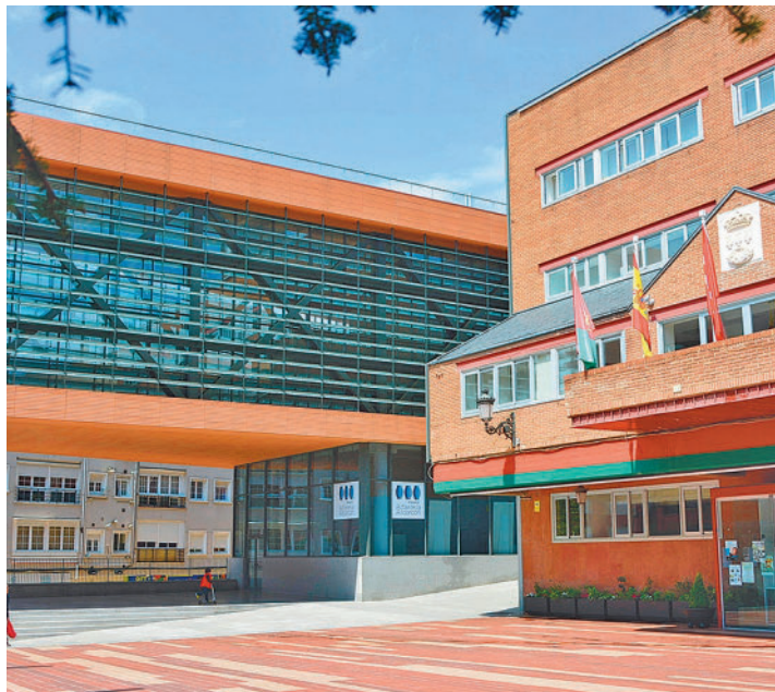
Fachada del Ayuntamiento de Alcorcón
