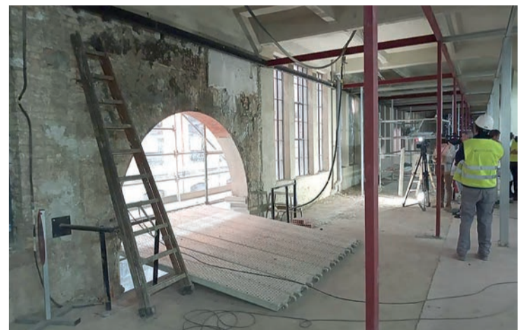
Los trabajos en el Mercado de San Blas.
