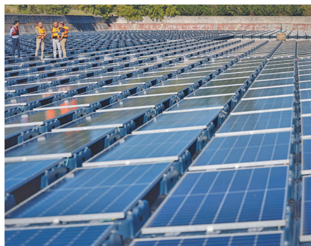
Instalación fotovoltaica de Torrelaguna
