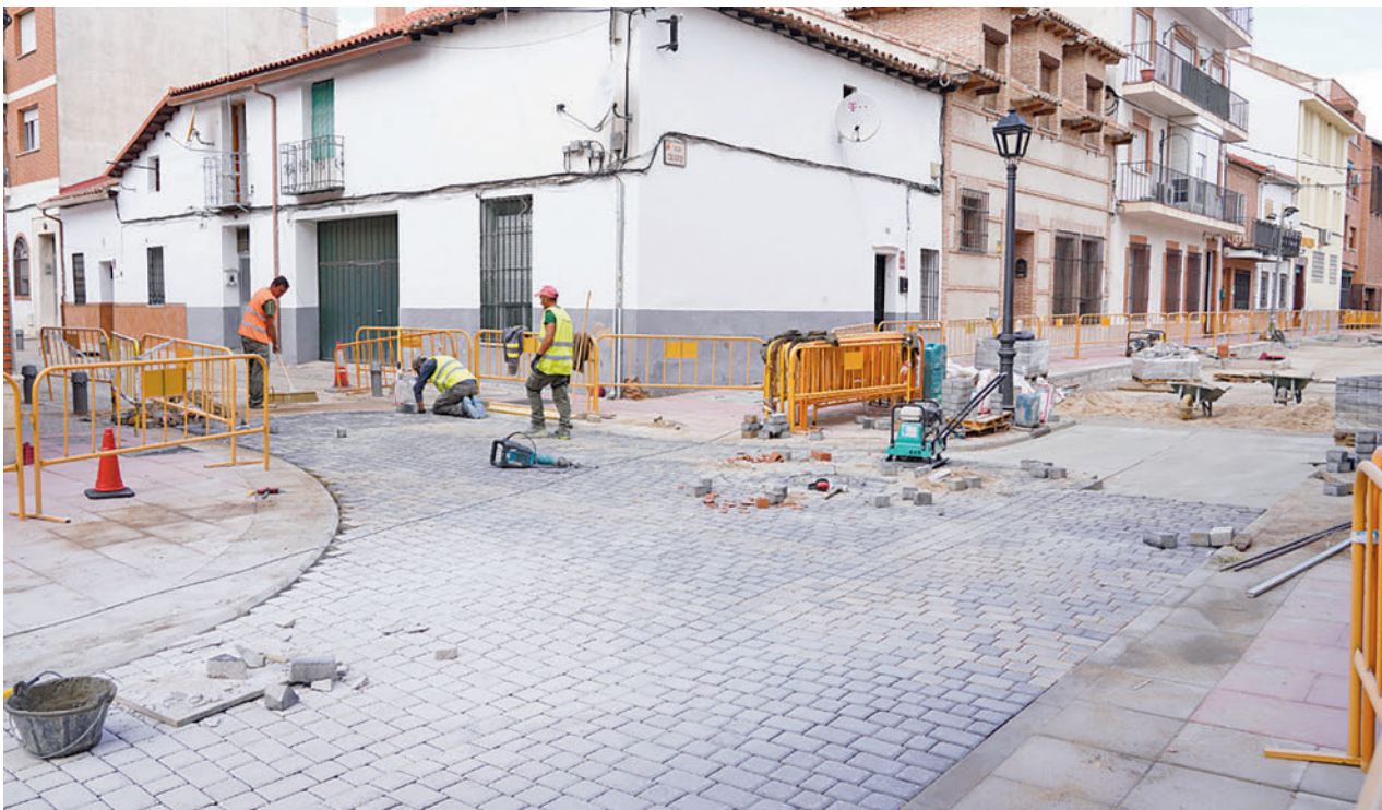
Zona en la que se están llevando a cabo los trabajos
