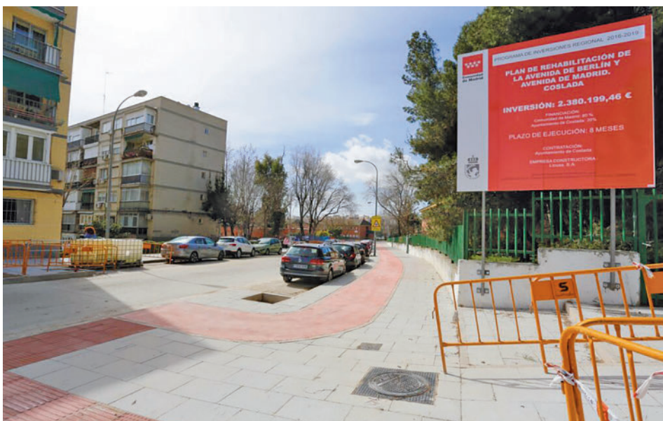
Zoan en la que se están realizando las obras
