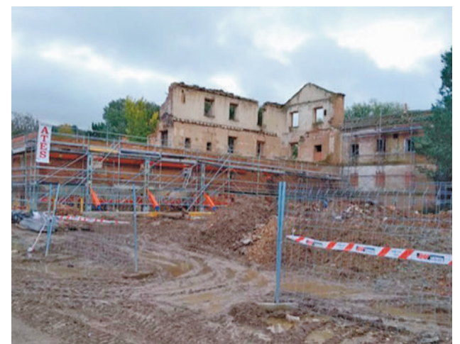
Obras de rehabilitación del molino
