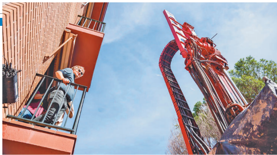
Obras en las viviendas afectadas por la Línea 7B E.P.
