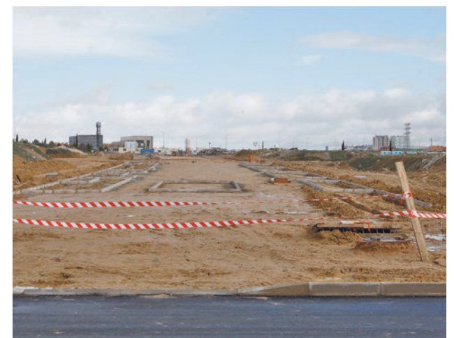
Las obras de urbanización, con el Ensanche al fondo
