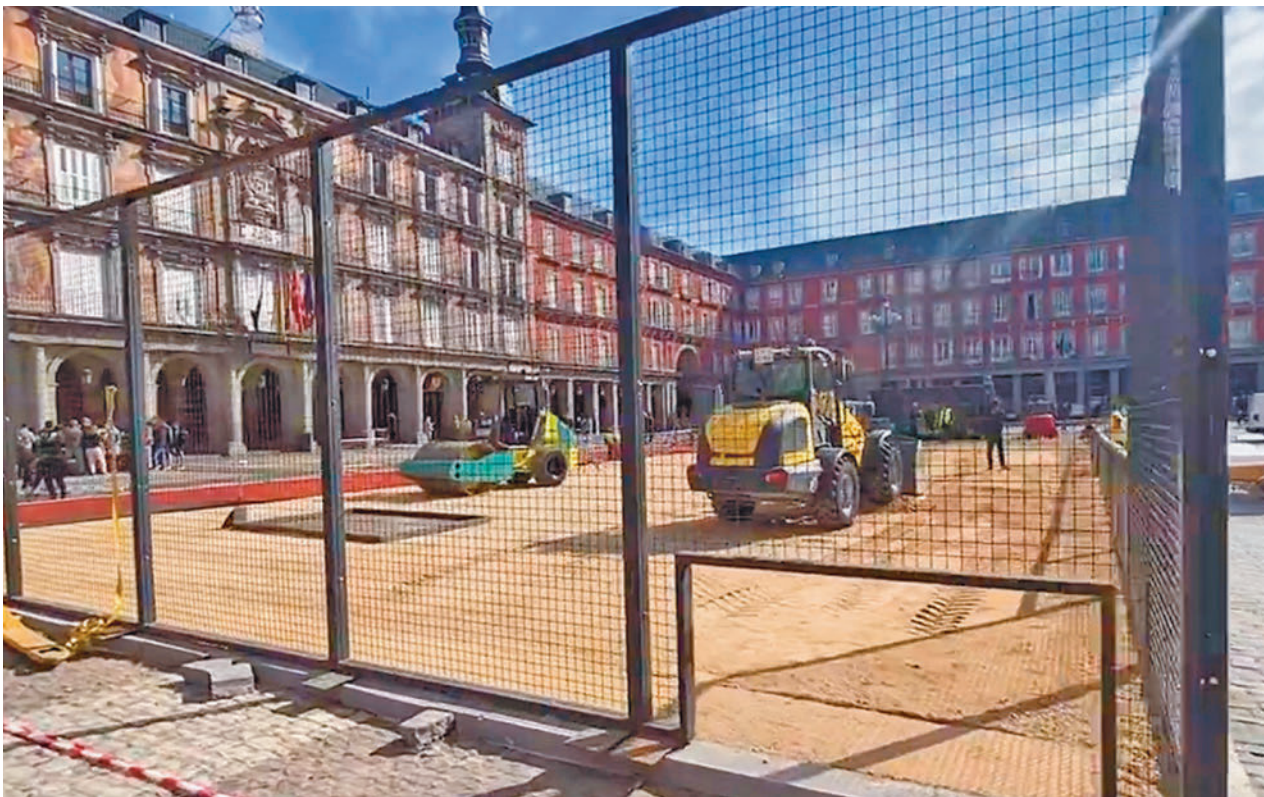
Los trabajos de instalación del recinto deportivo en pleno corazón de la capital @MADRIDDECADENTE
