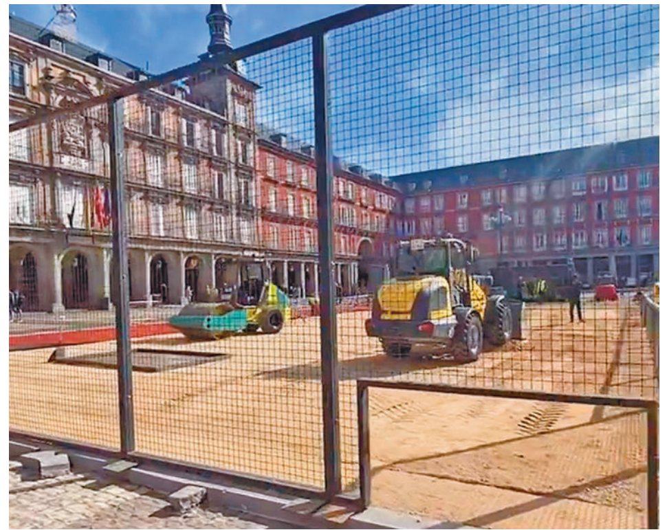
Los trabajos de instalación del recinto deportivo en pleno corazón de la capital @MADRIDDECADENTE
