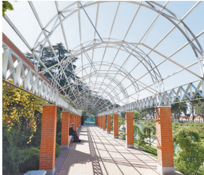
Las pérgolas metálicas de la rosaleda del parque del Oeste
